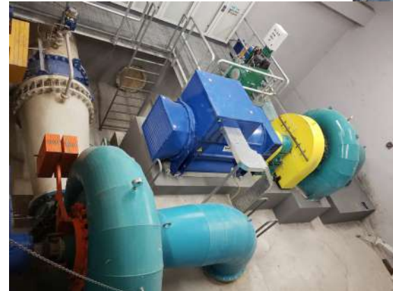
Fotografía: PMGD Los Portones Construcción SCOTTA Chile Spa
