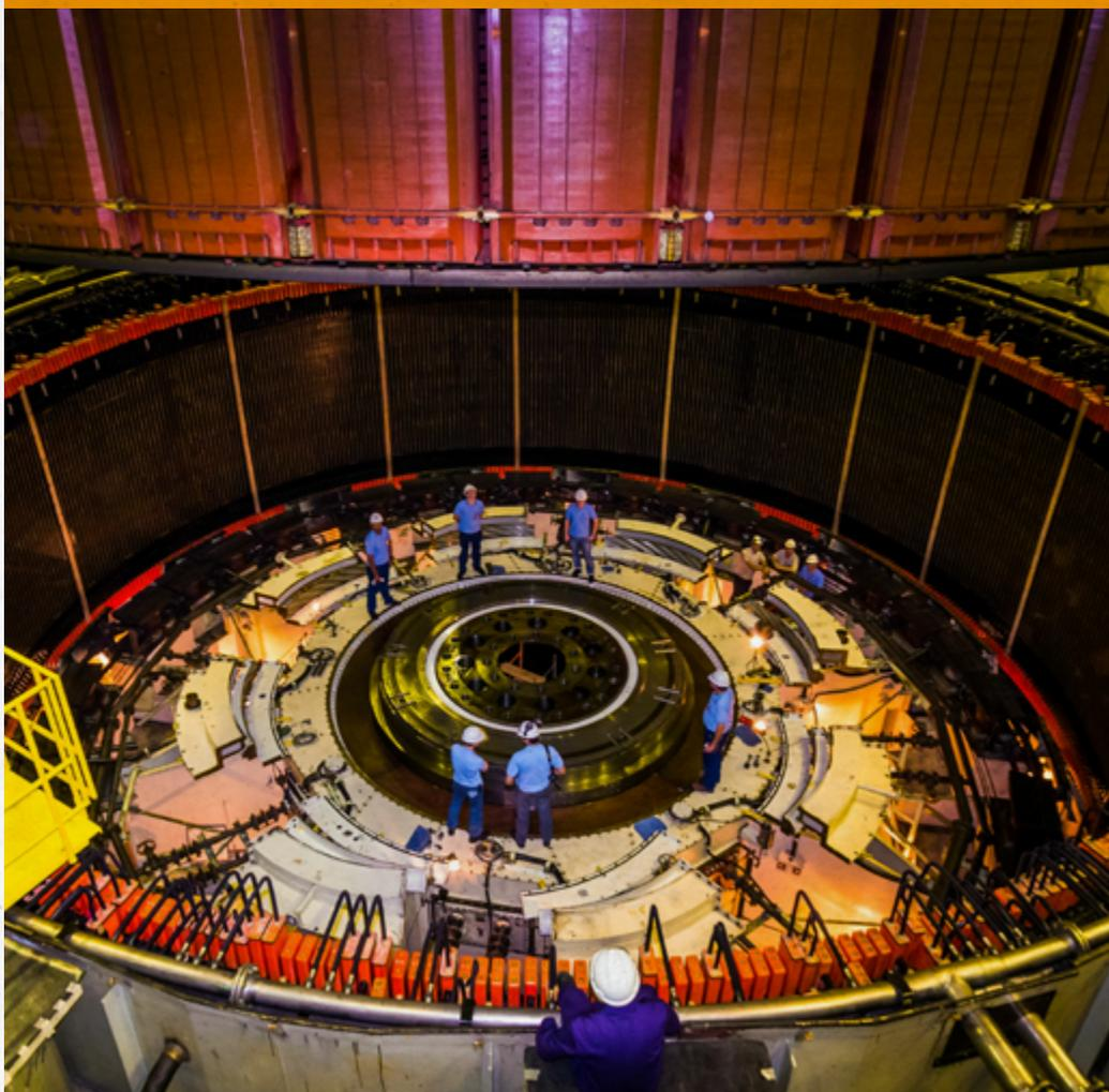
Retiro del estator de la Unidad 6 – Usina de Itaipu. Foto: Alexandre Marchetti / Colección Itaipu Binacional
